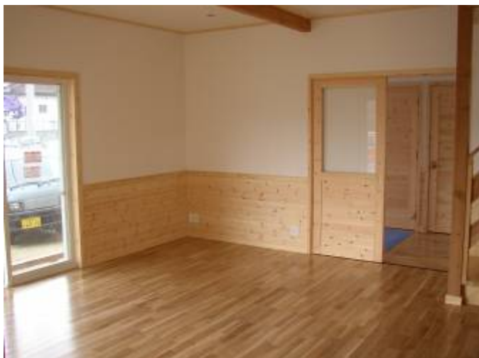
ナラ材の無垢板フローリングとレッドパインの横貼り。 天井には化粧梁を取り付けております。
