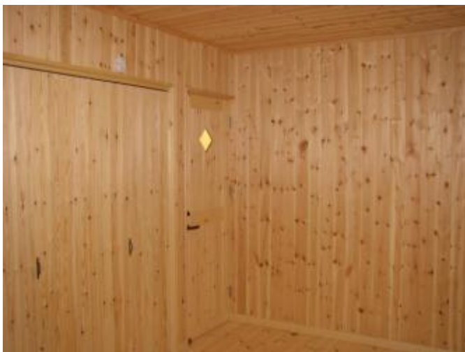
主寝室や子供室も赤松の無垢板貼りです。 クローゼット折れ戸やドアも手造りです。
