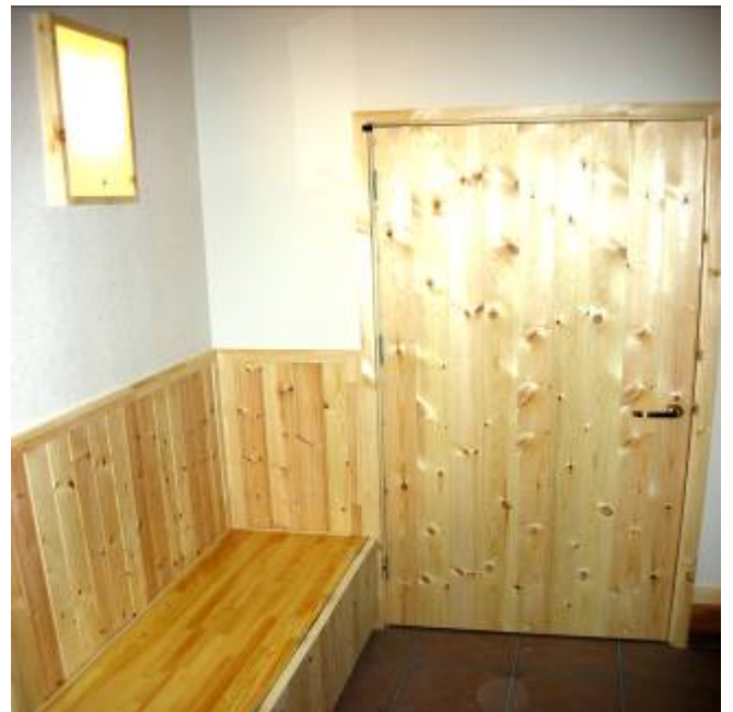
玄関造り付けベンチは、下足入れ兼用です
