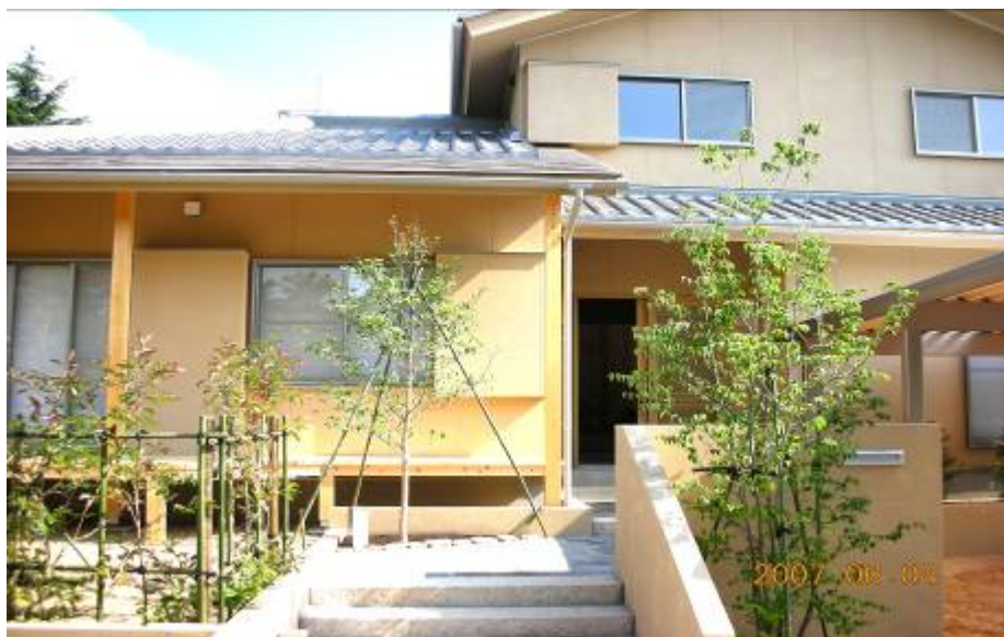
玄関階段に、錆御影延べ石 アプローチ部分に、諏訪の鉄平石乱貼り
