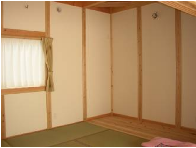
天井：踏天井（梁表し）杉(7)40 柱：杉 KD 材プレーナー仕上げ
