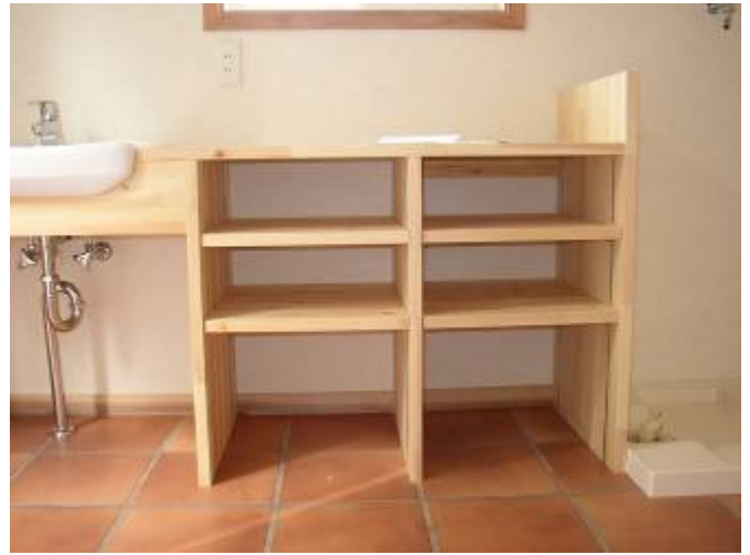
洗面台・収納：レッドパイン積層材
